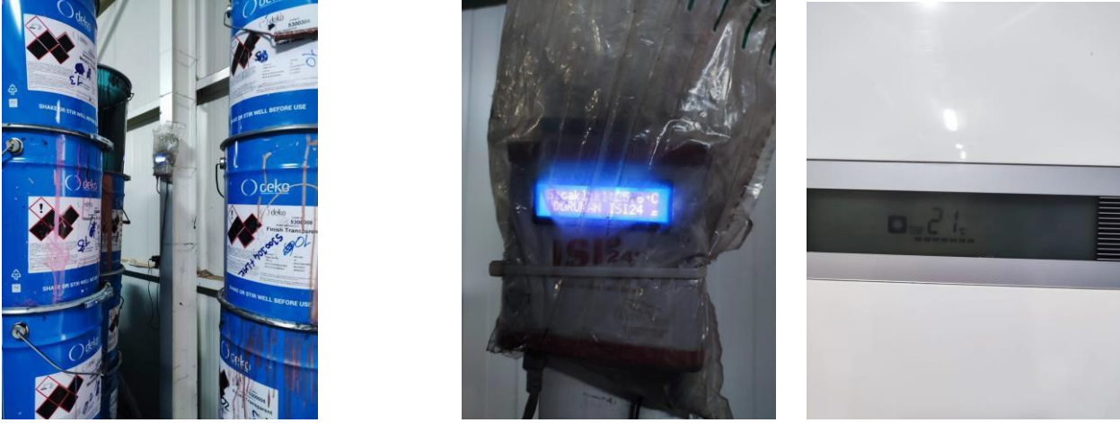
Şekil 8. Depolara klima koyulması ve ortam sıcaklığının kontrol altında tutulması
